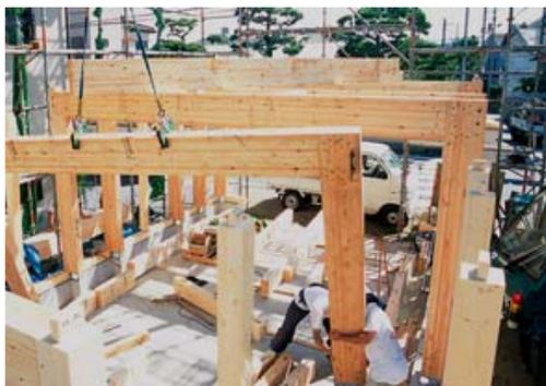
※ ジューテックの木造門型フレーム「J-FRAME」は建築住宅の階数（二階建てでも、平屋でも）に関わらず、全て許容応力度計算法を必要とします。
